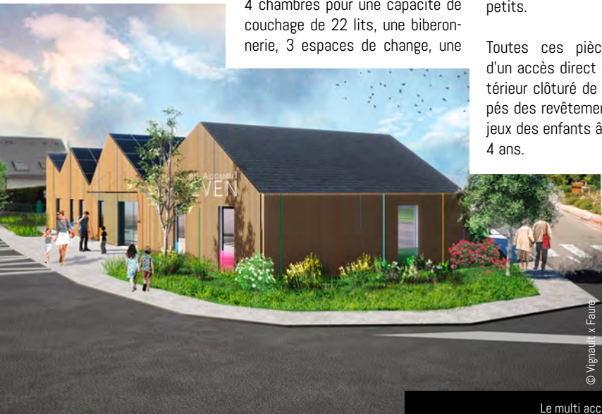
Le multi accueil sera construit en ossature bois et doté de panneaux photovoltaïques.
