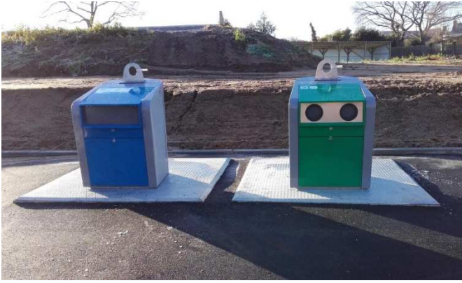
Colonnes enterrées, Camors
