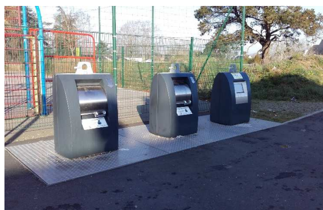
Colonnes enterrées, Gumenen à Auray
